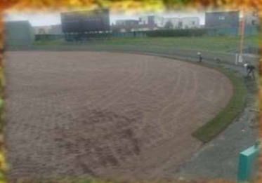
曲線部の芝張り
