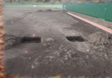
ブルペン基礎工事
