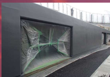
壁面の衝撃吸収材施工
