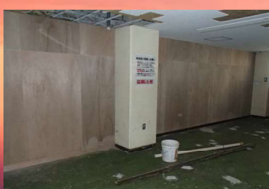
建物内諸室の改修
