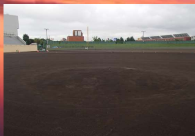
ピッチャーマウンド造成中
