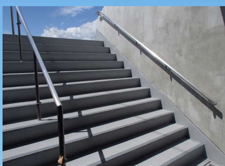
階段の防水塗装中
