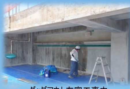
ダッグアウト左官工事中
