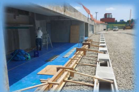
ダッグアウト前の基礎工事
