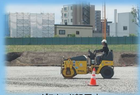
グラウンド転圧中
